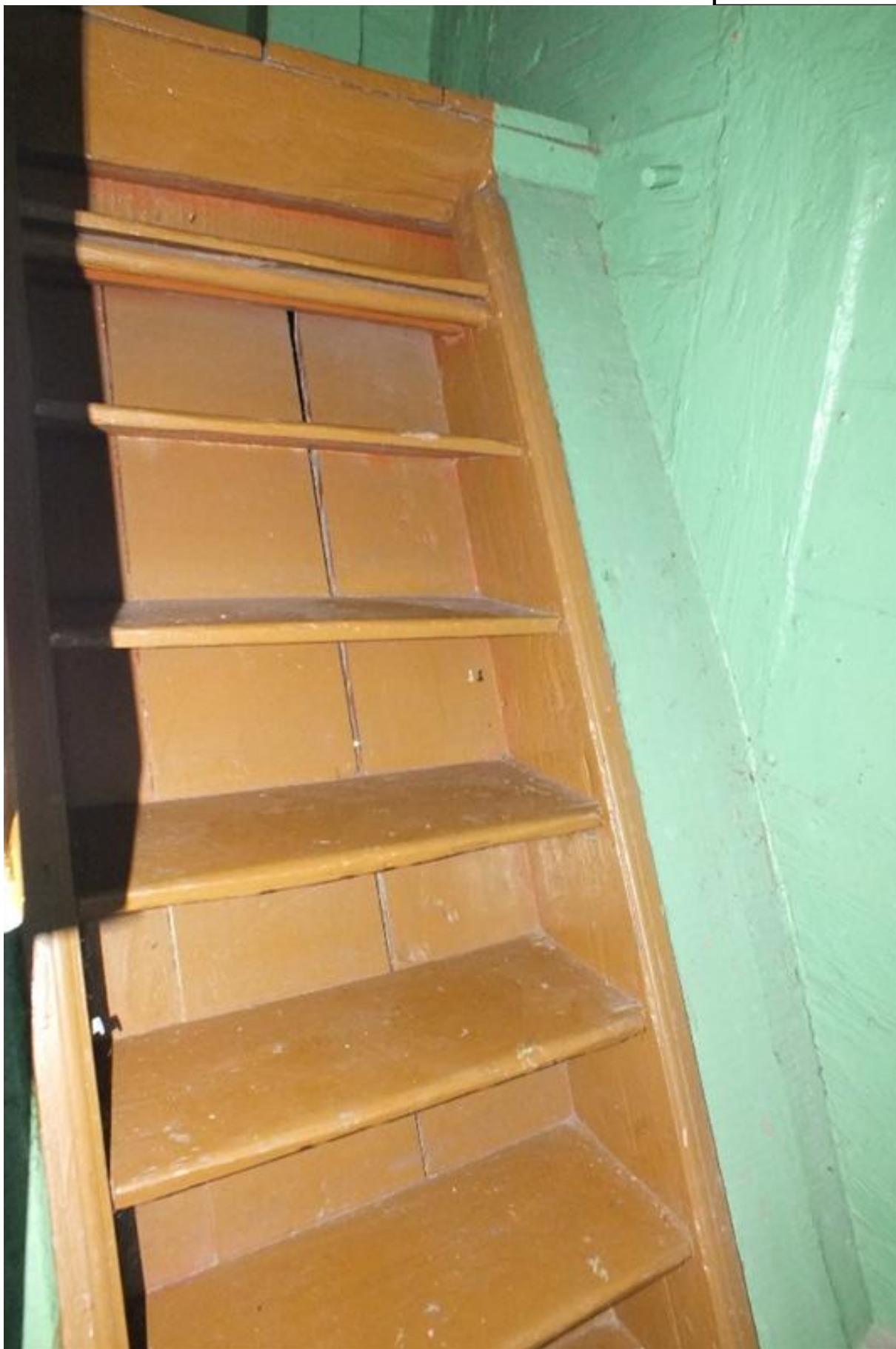
Nr. 118 Pavadinimas Šiaudinės Švč. Mergelės Marijos bažnyčia. Interjeras. Laiptai iš zakristijos į sakyklą ir ŠR emporą Fotografavo Violeta Bruzgelevičiūtė Data 2015-02-10
