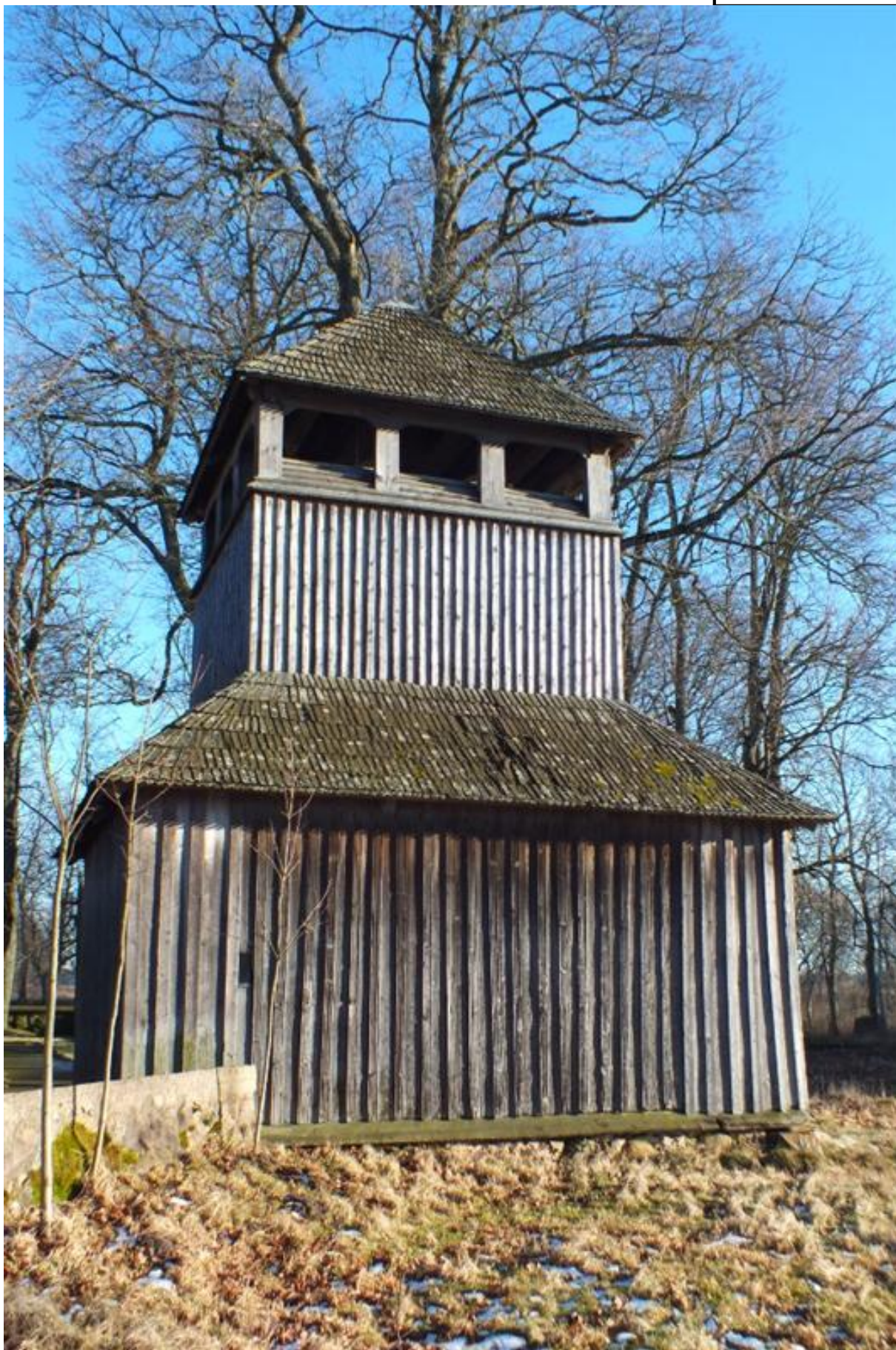
Nr. 196 Pavadinimas Varpinė. ŠV fasadas Fotografavo Violeta Bruzgelevičiūtė
