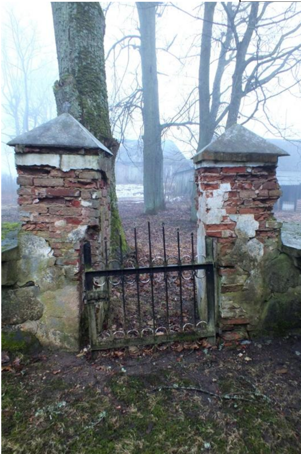
Nr. 21 Pavadinimas Šiaudinės Švč. Mergelės Marijos bažnyčios pastatų kompleksas. Varteliai šventoriaus tvoros PV dalyje. Vaizdas nuo šventoriaus pusės Fotografavo Violeta Bruzgelevičiūtė Data 2015-02-10
