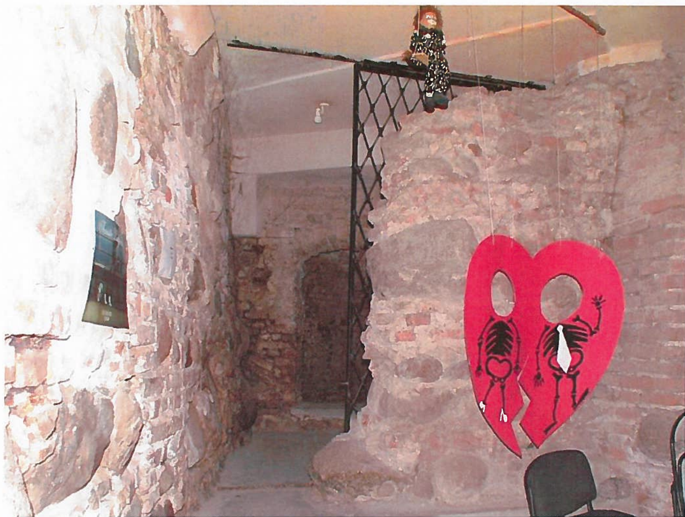
Pastato rūšiai. Patalpa Nr. 4. Bendras vaizdas 20 / 26 | Ieva Grabytė | 2007-03-29 FF20
