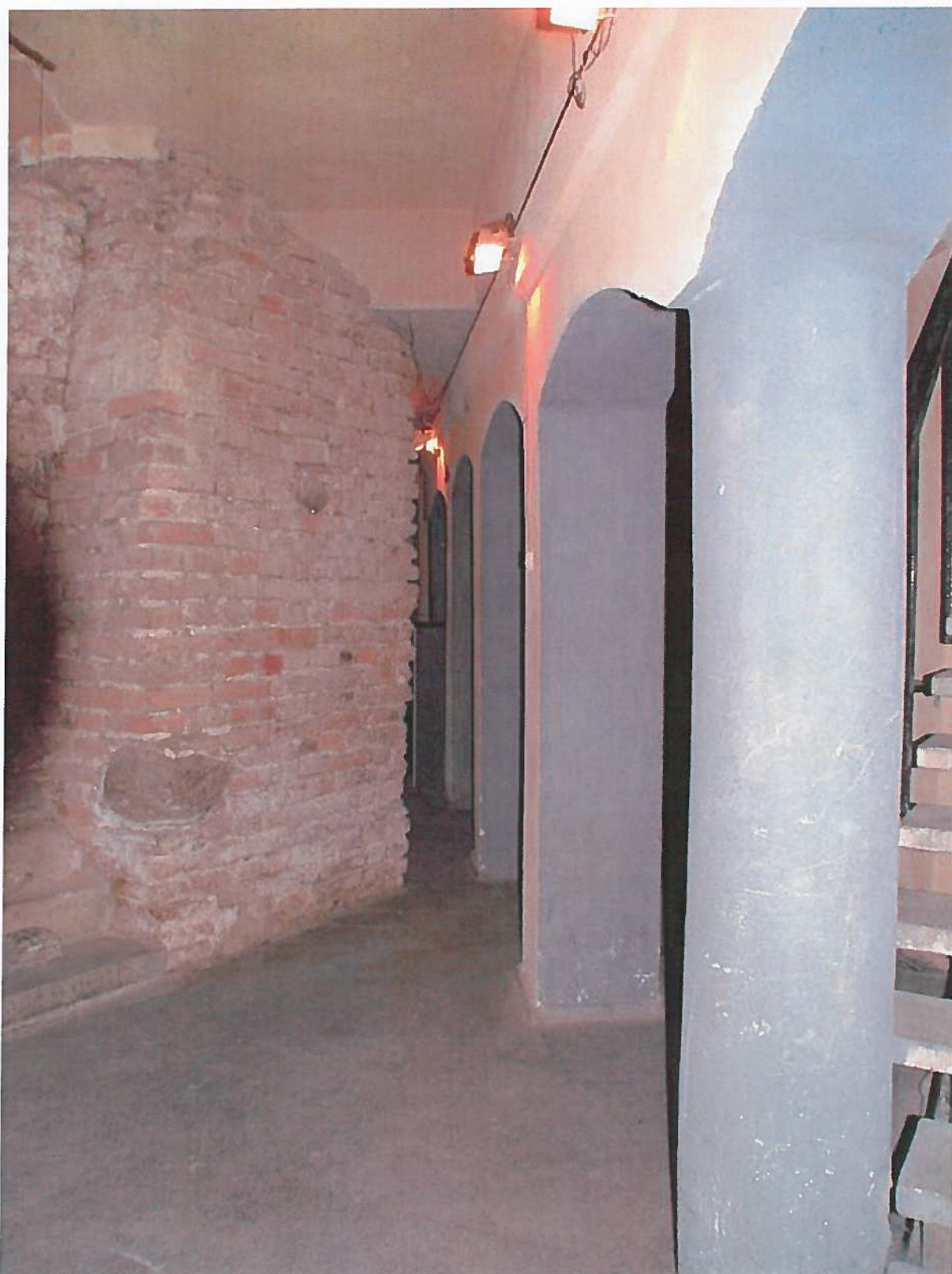
Pastato rūšiai. Patalpa Nr. 4. Bendras vaizdas 18 / 26 | Ieva Grabytė | 2007-03-29 FF18
