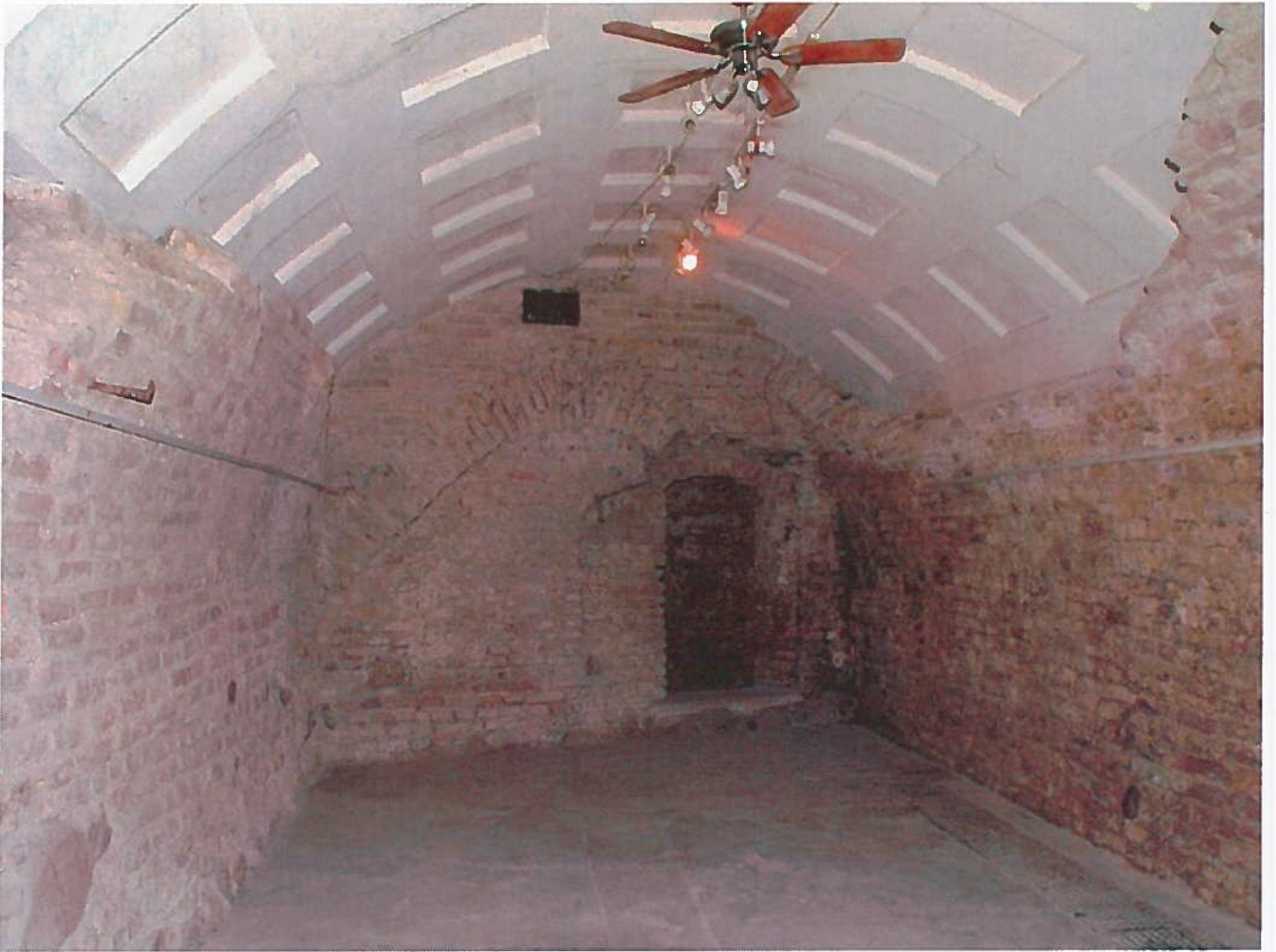
Pastato rūšiai. Patalpa Nr. 1. Bendras vaizdas 2 / 26 | Ieva Grabytė | 2007-03-20 FF2
