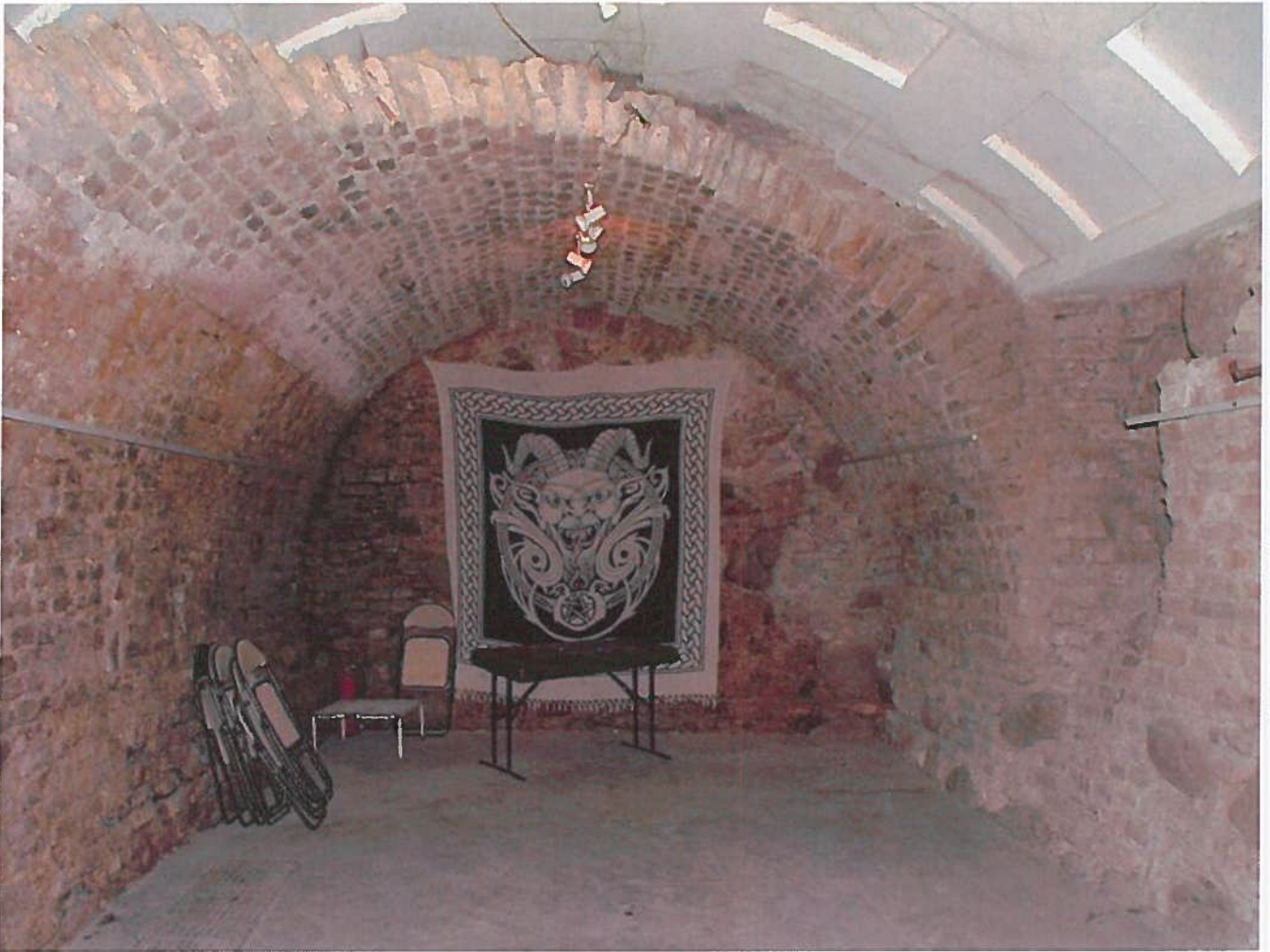
Pastato rūšiai. Patalpa Nr. 1. Bendras vaizdas 1 / 26 | Ieva Grabytė | 2007-03-20 FF1
